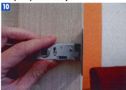
10 Легче всего наметить место для отверстия под квадрат ручки, используя саму защёлку. Нужно только учитывать глубину паза под накладную планку.
