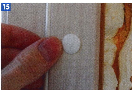
15 Последний штрих — установка заглушек на крепёжные отверстия в коробке.
