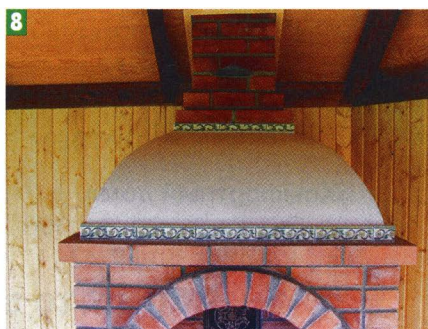
Епанчу оштукатурил по металлической сетке, зашпатлевал и покрасил в белый цвет. Сверху и снизу декорировал керамическим бордюром.
