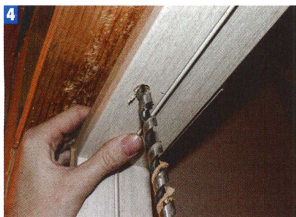
4 При креплении коробки сначала высверливал глухое отверстие большого диаметра, чтобы утопить головку самореза.
