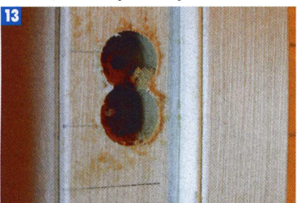
13 Для выборки паза под ответный механизм на стойке сначала высверлил два отверстия, после чего подровнял края стамеской.
