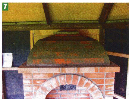
По опалубке выкладывал свод из напильного кирпича, выпуская в некоторых местах вязальную проволоку для закрепления штукатурной сетки.
