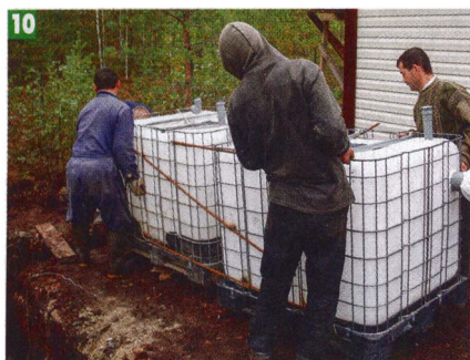
10 Установка септика из двух секций оказалась сложной задачей.
