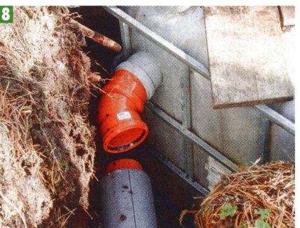
8 Подключение еврокуба к канализационной трубе.
