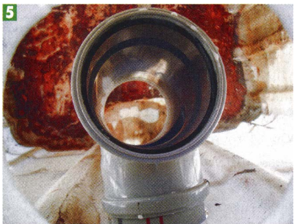
5 Установленный тройник (вид изнутри).
