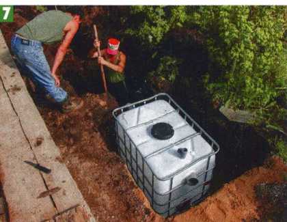
7 Одинарный септик для кухни установлен.
