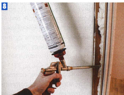
8 Лучше использовать пену с низким коэффициентом расширения и наносить её в несколько проходов.
