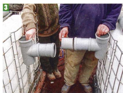
3 Для соединения ёмкостей между собой использовал серые канализационные трубы и фитинги.
