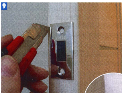
9 Намечаю паз под накладную планку и выбираю его, по возможности аккуратно снимая плёночное покрытие.
