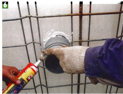
6 При установке труб стыки тщательно промазывал герметиком.
