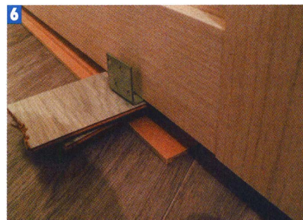
6 Для фиксации полотна на нужной высоте подойдут любые подручные материалы.
