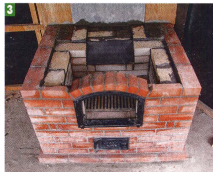
3 ...и лишь после этого — внутренние стенки из шамотного.
