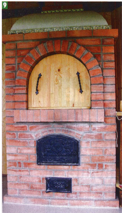
Деревянная заслонка помогает сохранять тепло в варочной камере.
