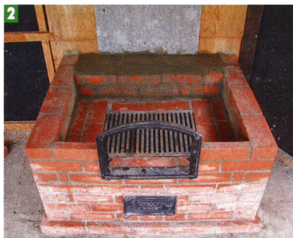
2 Топку выкладывал в два приёма. Сначала — наружные стенки из печного кирпича...
