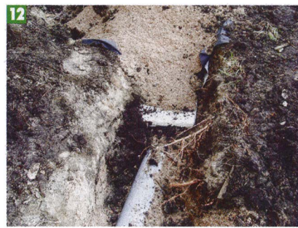
12 Канализационные трубы также проложены сверху листами утеплителя и засыпаны грунтом.
