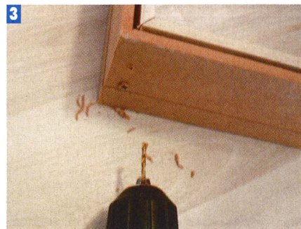
3 Чтобы брус не лопнул, сверлю отверстие под саморез.
