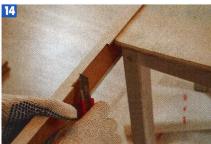
14 В одном из наличников делаю выборки в тех местах, где он упирается в саморезы, удерживающие петли.
