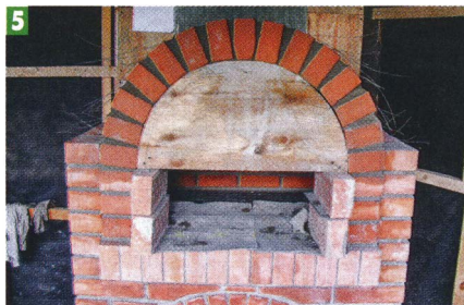
При кладке арки кирпичи, кроме замкового, не стёсывал на клин. В швы закладывал обломки кирпича, обмотанные вязальной проволокой, концы которой потом заводил в швы вышележащих рядов.
