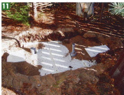
11 Для утепления септика с боков и сверху ёмкостей прокладывал листы пенополистирола.
