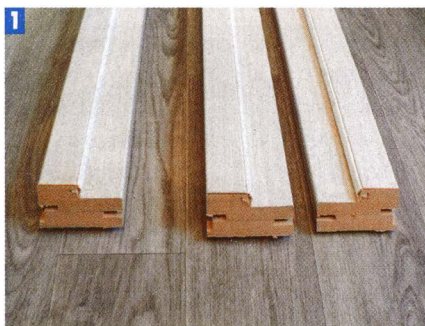
1 На брусках дверной коробки из МДФ установлен уплотнитель и выбраны пазы для монтажа наличников и доборных досок.
